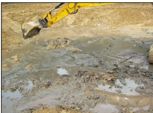
Excavations des matériaux pollués sous géomembrane
