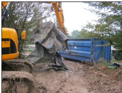
Evacuation de la géomembrane
