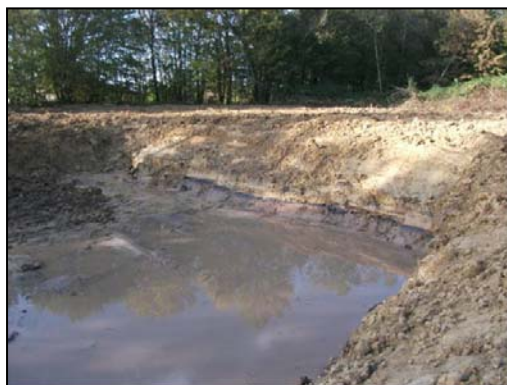
Excavations des matériaux pollués sous géomembrane
